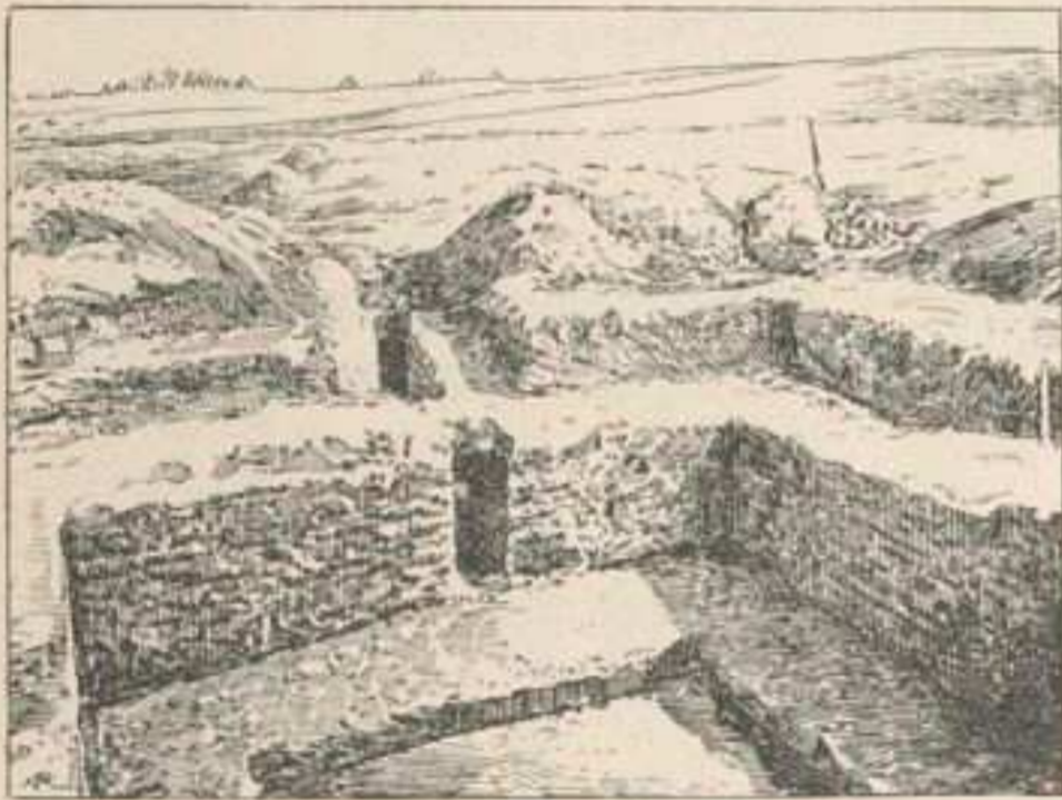
9785. — Arrivée de la grande rigole de Wissous. D'après de Pachtère, op. cit. , pl. IV, n. 1.
